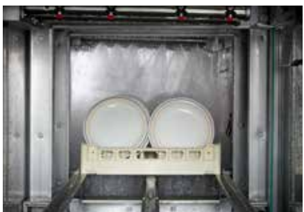
Zona de lavado
